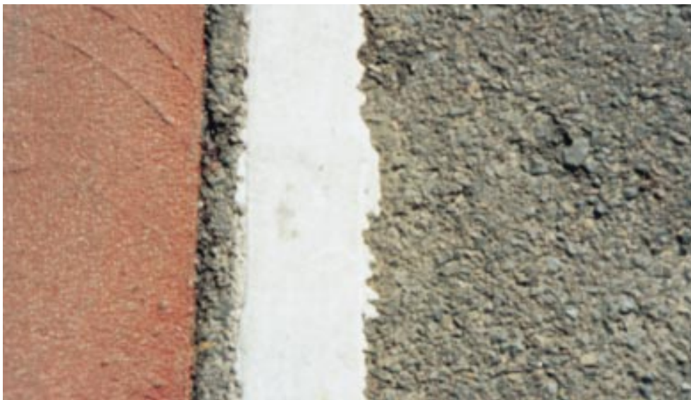
Abb. 4.3.2: Weiße Kaltplastikmarkierung als Trennlinie
