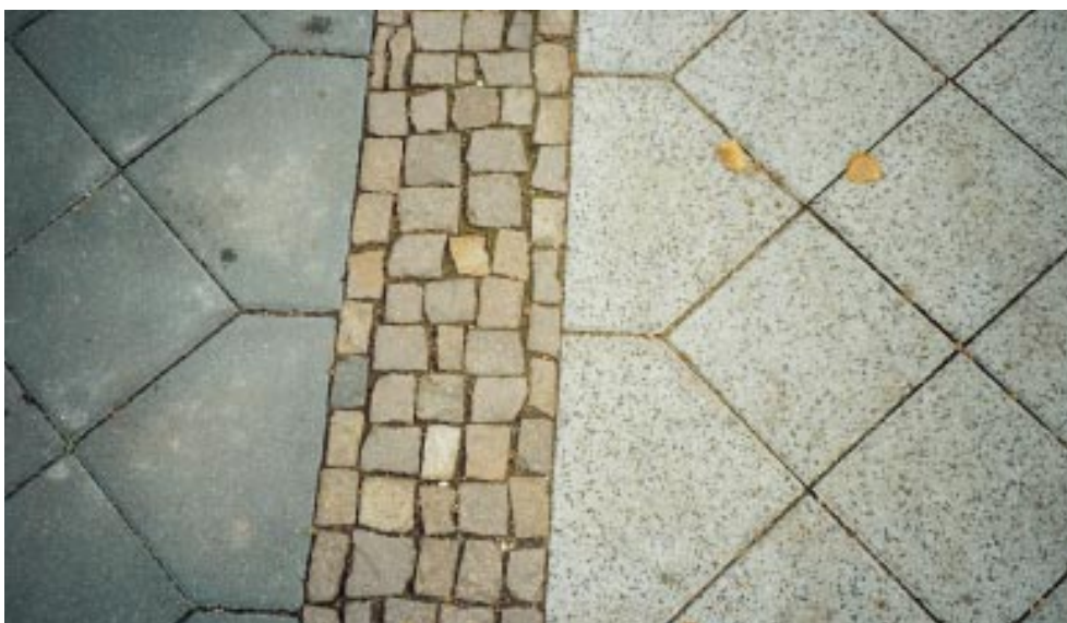
Abb. 4.2.1: Trennung zwischen Gehweg und Radweg
